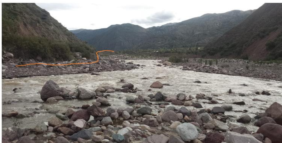
FIGURA N°02: SE OBSERVA SOCAVACIÓN EN LA MARGEN IZQUIERDA PRODUCTO DEL INCREMENTO DEL CAUDAL DEL RIO CACHI
