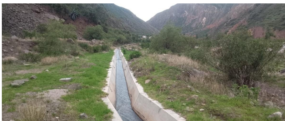
FIGURA N°05: SE OBSERVA CANAL DE RIEGO EN RIESGO POR NO CONTAR DEFENSA RIBEREÑA EN EL RIO CACHI
