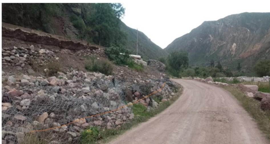
FIGURA N°03: SE OBSERVA DEFENSA RIBEREÑA ANTIGUA (GAVION) QUE ESTA COLAPSADO PRODUCTO DEL INCREMENTO DEL CAUDAL DEL RIO CACHI
