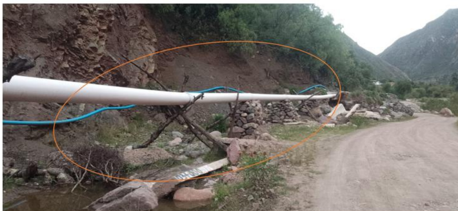
FIGURA N°04: SE OBSERVA CANAL DE RIEGO COLPASADO PRODUCTO DEL INCREMENTO DEL CAUDAL DEL RIO CACHI
